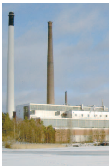
In Skandinavien prägen Großanlagen den Pelletsmarkt, wie hier das Pellets-Heizkraftwerk Hässelby
